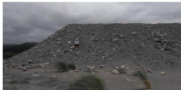
圖三十一 擋水砂石牆(約5層樓高)
