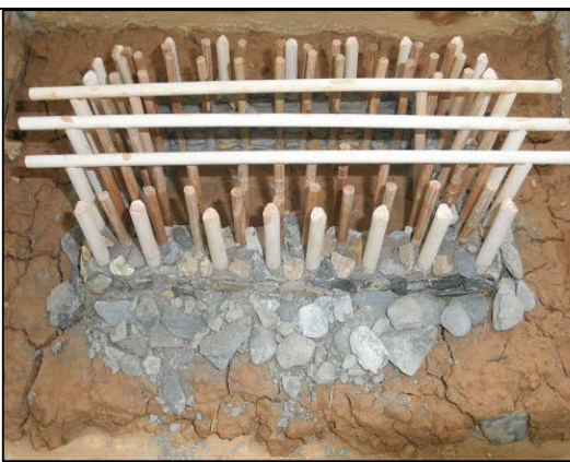
圖二十一 完成砌石與豎立樑柱
