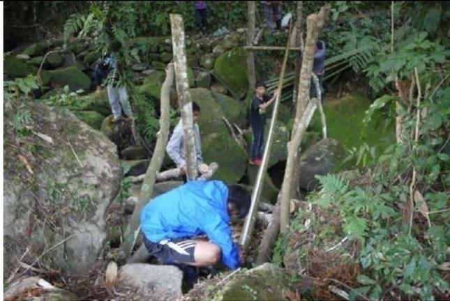
利用 45 度的斜木，增強整個基座的穩固度
