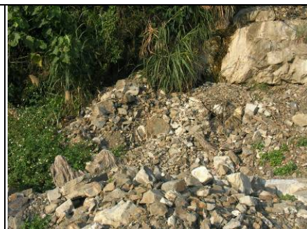
C：靠溪邊的邊坡
