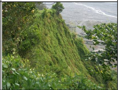
9 舊 21 線道旁，已大規模坍塌過
