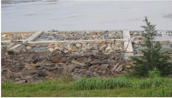
圖四、卑南溪防護措施-水覆蓋法
