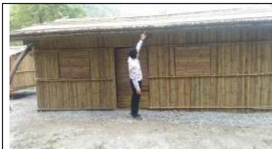
現代的家屋沿用日據的材料搭建
