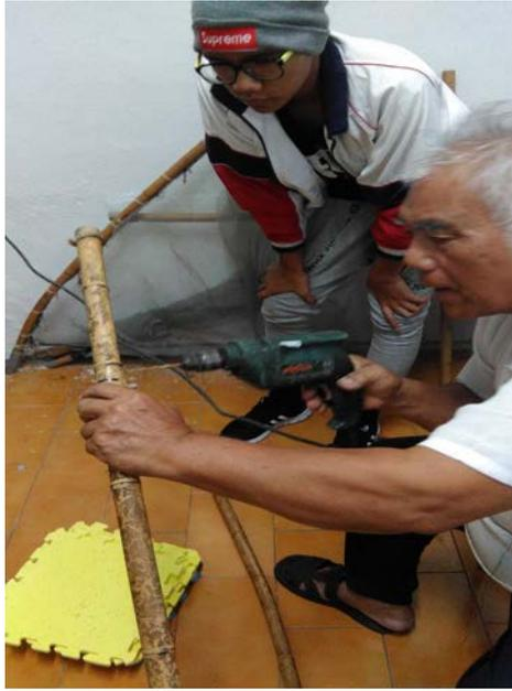
圖十四 竹節洞口調整
