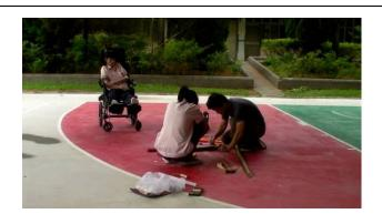
4. 最後再用砂紙磨平切割過的痕跡
